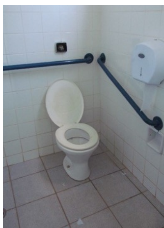
Figura 5A. Sanitários - Parque Centenário, Mogi das Cruzes, SP.
