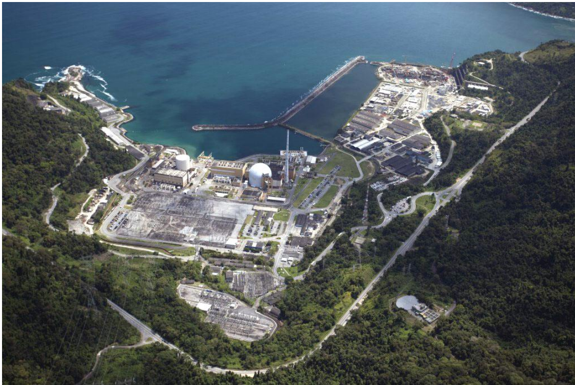
Figura 1 - Central Nuclear de Angra dos Reis no estado do Rio de Janeiro
