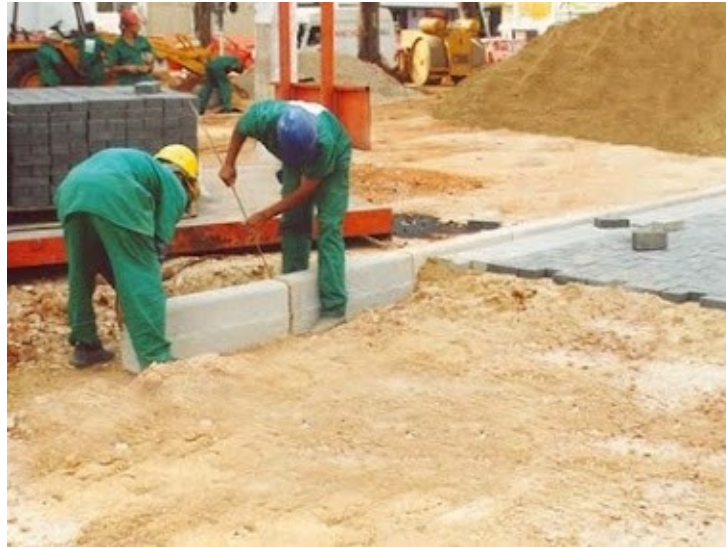
Figura 3: Guias sendo instaladas.
