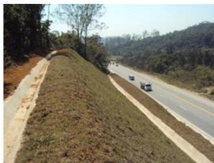
Figura 7: Talude com canaletas
